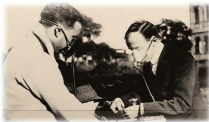
Zuloaga y Bradley probando los equipos de aire comprimido para la travesía en altura.
